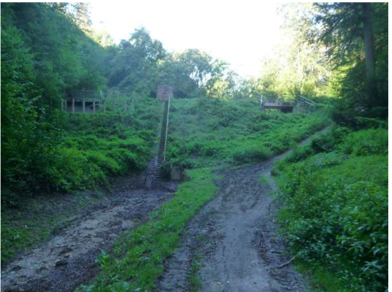
Staumauer der Schwäblerklinge
